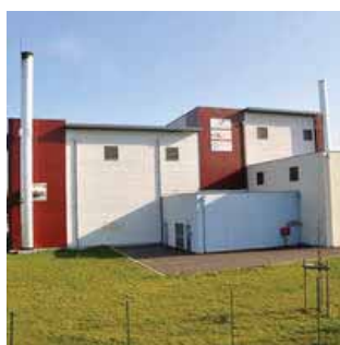
Chaufferie bois d'Andrézieux-Bouthéon - SIEL
