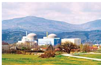
Centrale nucléaire de St-Alban St-Maurice - IRMA - Grenoble
