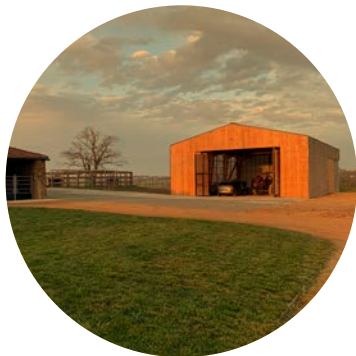
Hangar à Foin, Saint-Marcel-de-Félines, Fabriques.
